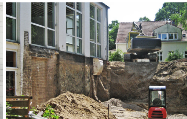
Die Baustelle im Juli 2017
